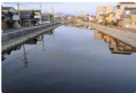
勢田川感潮域の風景。 両岸はコンクリートと石積みでガッチリ。 でもこんなところにアカエイが泳いでいるのです。
