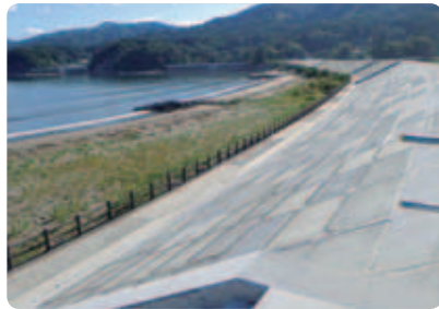
震災後、砂浜の背後につくられた巨大な堤防
